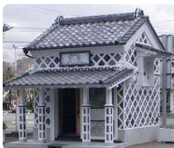
図1 破風板 懸魚 様々に装飾が施されたものがある。 左写真は伊豆松崎町「長八美術館」前にある「夢の蔵」。外壁と庇柱の腰が「海鼠壁」で施されている。
