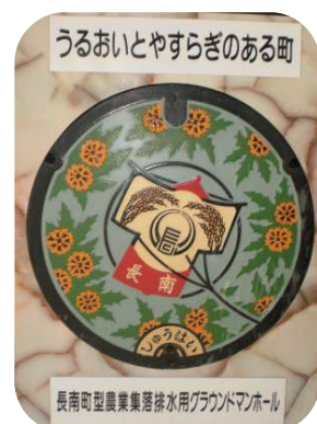
① 長南町型農業集落排水用グラウンドマンホール。
