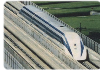
リニアの実験線。営業運転ではコンクリート壁で覆われる予定。写真は講演会資料より
