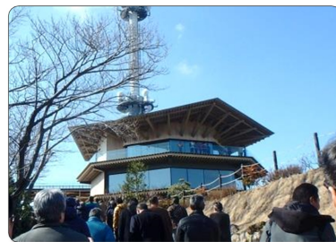
駐車場から夢テラスへ向かう登り坂歩道からの外観
