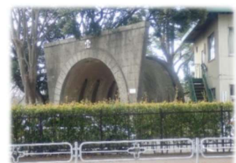
鉄道第一連隊トンネル工事ドーム跡
