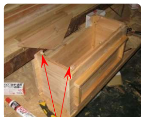
内隅に防水棧木取付け
