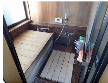
床と腰壁は大理石張り。すのこ敷き部分は、すのこ厚分下げて床を施工。
