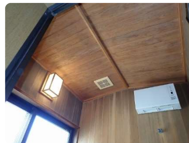
船底天井張り
