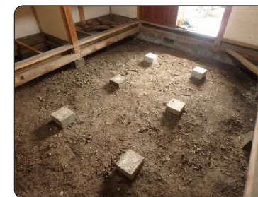
床下地施工前に清掃
